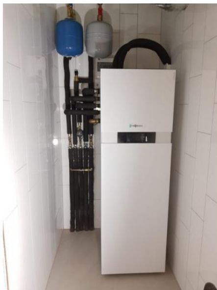
Slika 4. Dizalica topline zrak – voda, tip Vitocal 111-S, sa ostalom opremom
